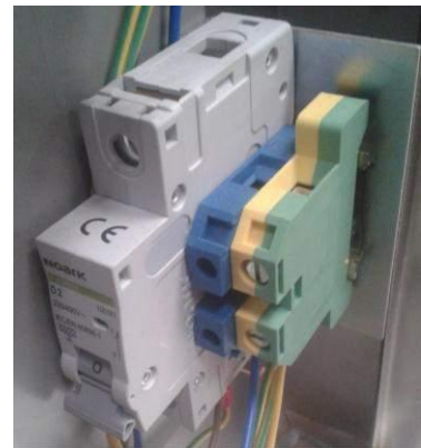
Рисунок 12– Подключение кабеля питания
