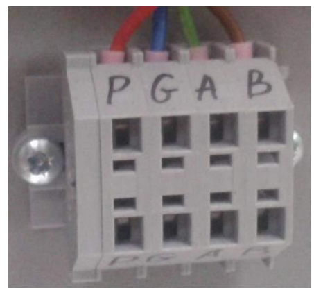
Рисунок 13 – Подключение кабеля связи с пультом управления к клеммам
